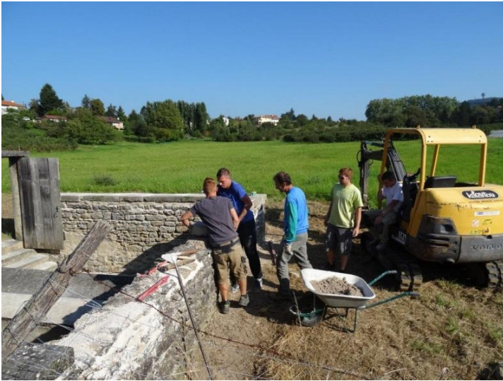
Après la pose des couvertines
